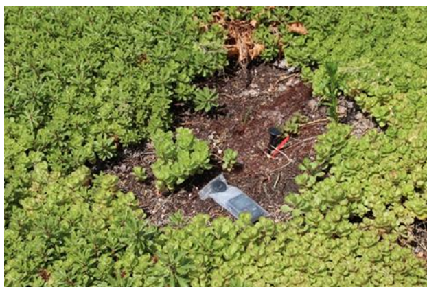
Рис. 2. Приклад негативного впливу температурного фактору на озеленення даху
