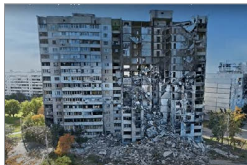
Рис. 8. Зруйнована багатоповерхівка на Північній Салтівці (м. Харків) Джерело: [19]
