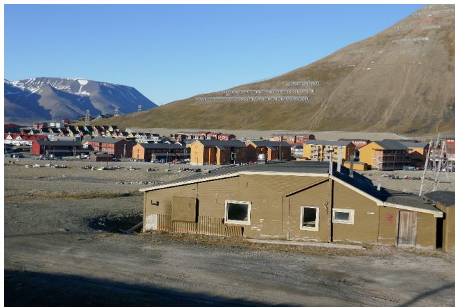
Fot. 1. Ogólny widok na jedno z osiedli w Longyearbyen i jego otoczenie. Na wzniesieniu, po prawej stronie widoczne zabezpieczenia przed lawinami śnieżnymi, które zimą mogą zagrażać mieszkańcom (Fot. Artur Zieliński 2022)
