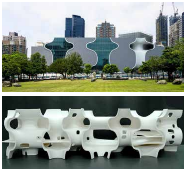
Рис. 15. Метрополітен-опера у м.Тайчжун та її майже 4- метрова модель, на основі мінімальної поверхні Шварца Р (Toyo ito: taichung metropolitan opera)
